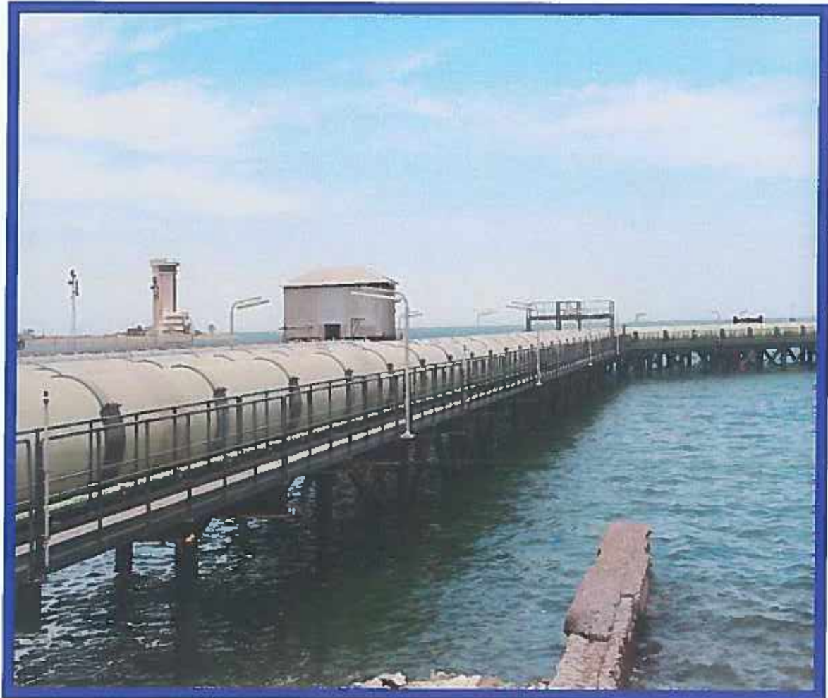
أنابيب مأخذ المياه لنظام محطة التناضح العكسي Pipes for water intake for reverse osmosis plant system
