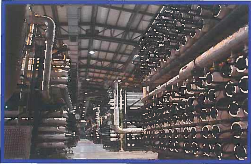
نظام معالجة المياه باستخدام التناضح العكسي Reverse Osmosis Water Treatment System
