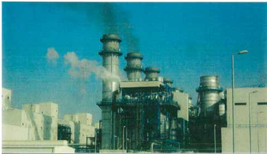
العادم الخارجي من المدخنة الرئيسية للغلاية رقم 12 التي تعمل بالاسترجاع الحراري وذلك نتيجة لتنظيف (نفخ) المواسير Power Block # 1 Combined Sigma Blowing
