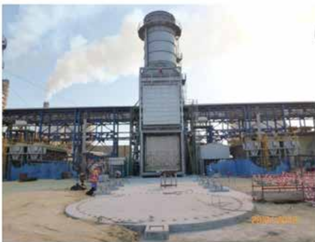
منطقة الخلاية التي تعمل بنظام الاسترجاع الحراري للوحدة 12 HRSG Unit 12 Area
