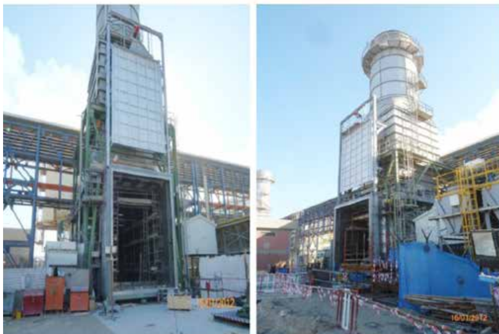
أعمال التركيبات لبوابة تحويل الغازات للوحدتين 22 و 31 Erection Works for Diverter Damper Units 22 & 31
