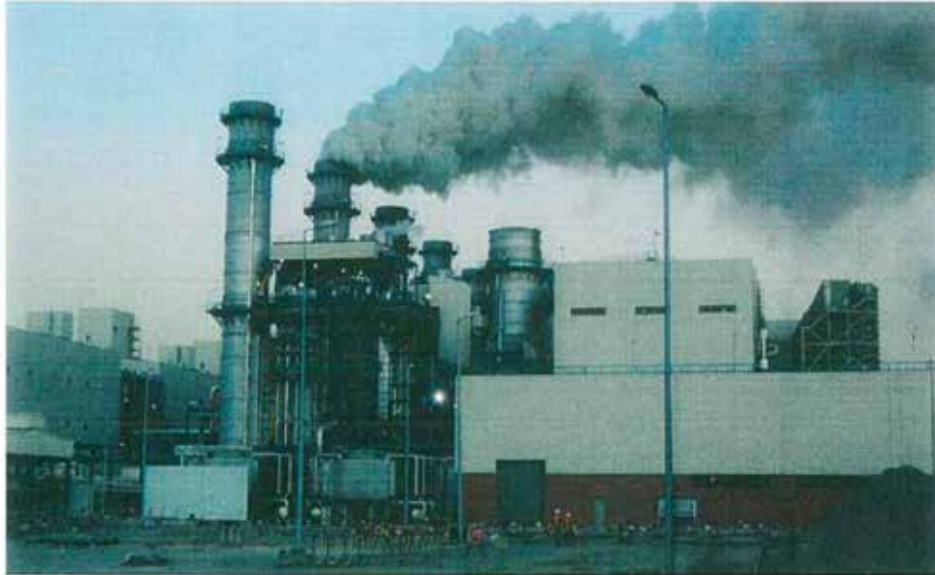
المدخنة الرئيسية لعادم الغازات الخارجة من تنظيف (نفخ) مواسير الغلاية رقم 12 التي تعمل بالاسترجاع الحراري HRSG#12 Main Stack Sigma Blowing
