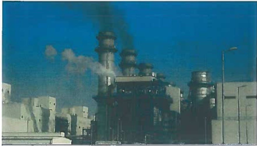
العدم الخارج من المدخنة الرئيسية للغلاية رقم 12 التي تعمل بالاسترجاع الحراري وذلك نتيجة لتنظيف (نفخ) المواسير Power Block # 1 Combined Sigma Blowing
