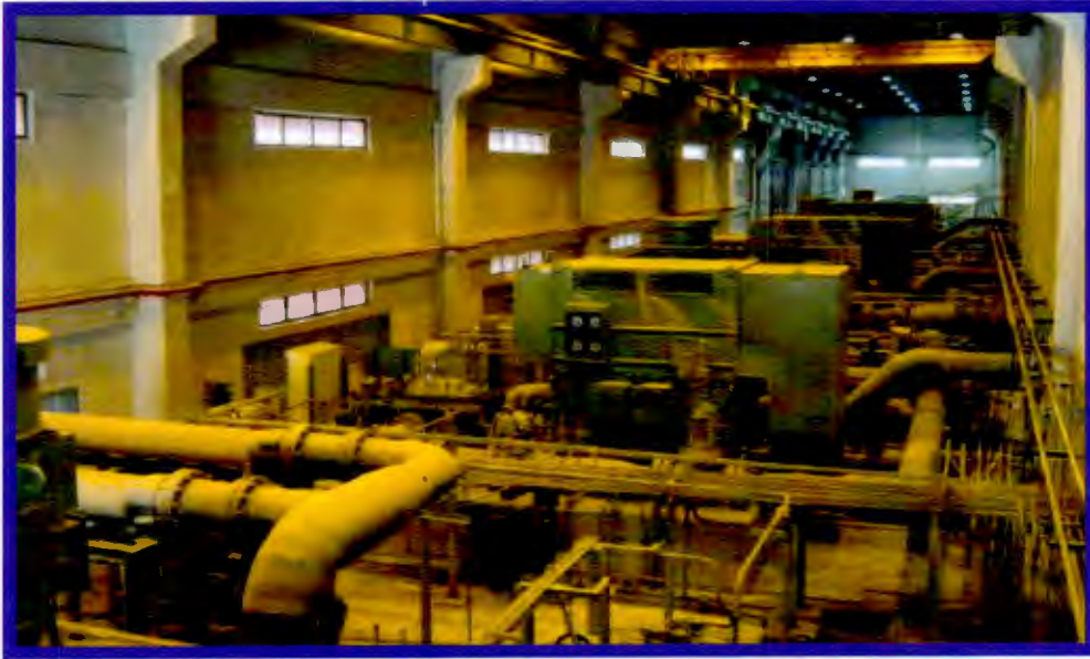
غرفة مضخات وحدة التناضح العكسي بمحطة الشويخ OR System Pump Room At Shuwaikh Station
