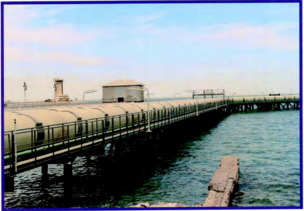
أنابيب مأخذ المياه لنظام محطة التناضح العكسي Pipes for water intake for reverse osmosis plant system
