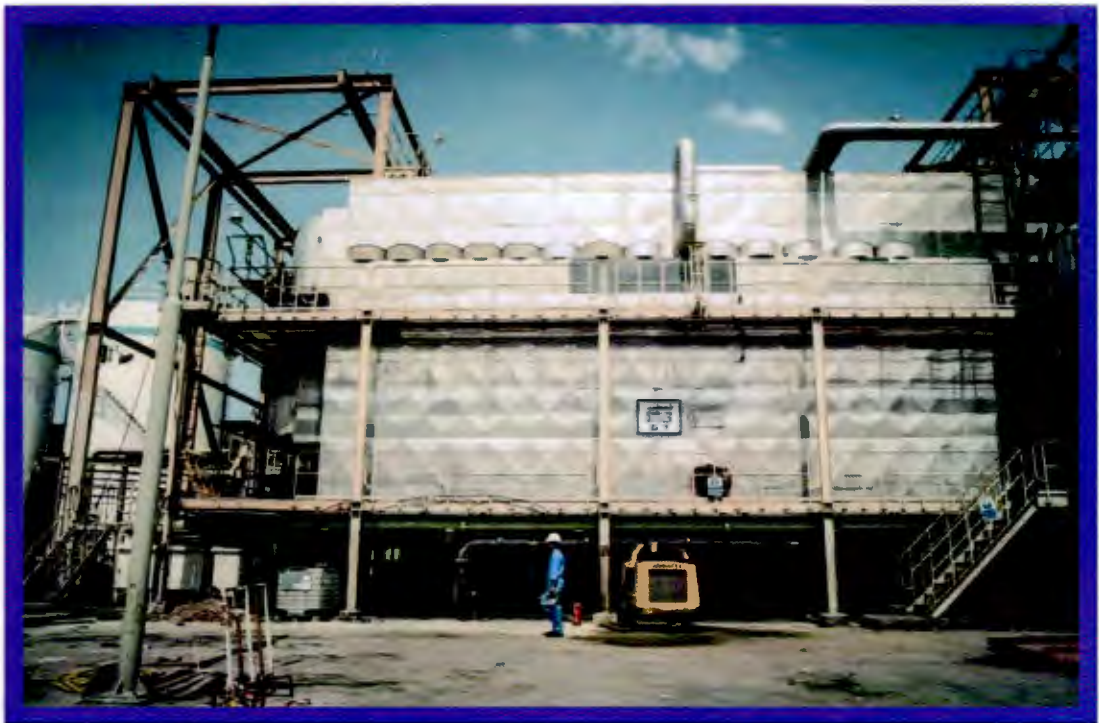
مقطرة مياه بتقنيه التبخير الومضي المتعدد المراحل
