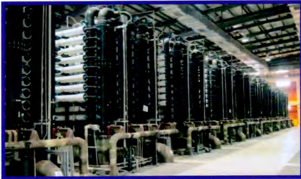
وحدات الأغشية فائقة الترشيح بمحطة الشويخ UF System – Membrane Trains at Shuwaikh Station
