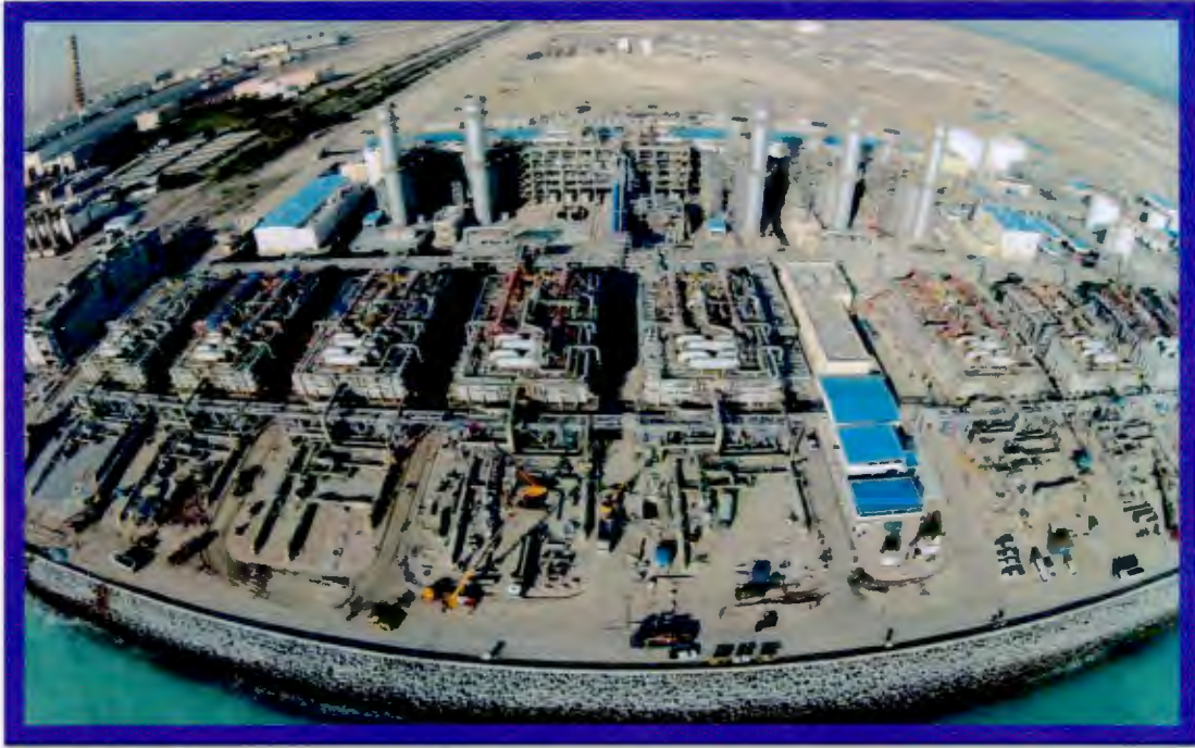
محطة الزور الشمالية قبل الانتهاء من مرحلة البناء
