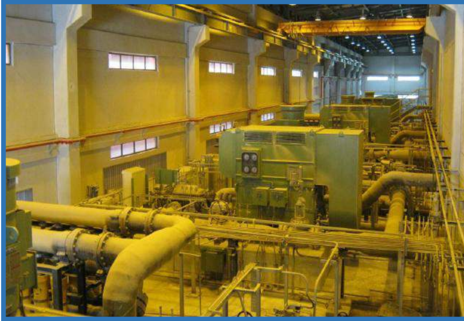
غرفة مضخات وحدة التناضح العكسي بمحطة الشويخ RO System Pump Room At Shuwaikh Station
