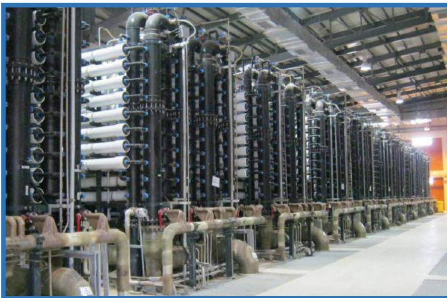
غرفة مضخات وحدة التناضح العكسي بمحطة الشويخ OR System Pump Room at Shuwaikh Station
