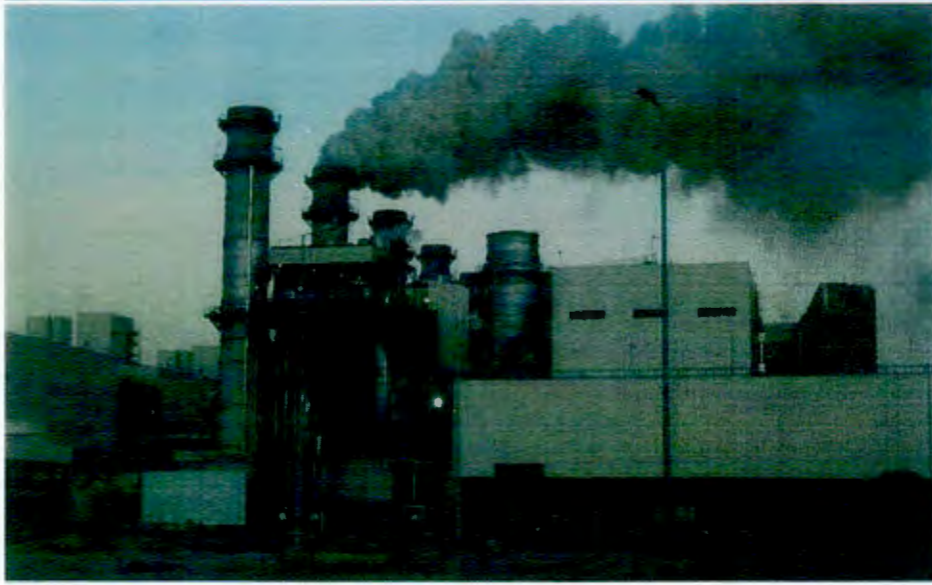
المدخنة الرئيسية لعادم الغازات الخارجة من تنظيف (نفخ) مواسير الغلاية رقم 12 التي تعمل بالاسترجاع الحراري HRSG #12 Main Stack Sigma Blowing
