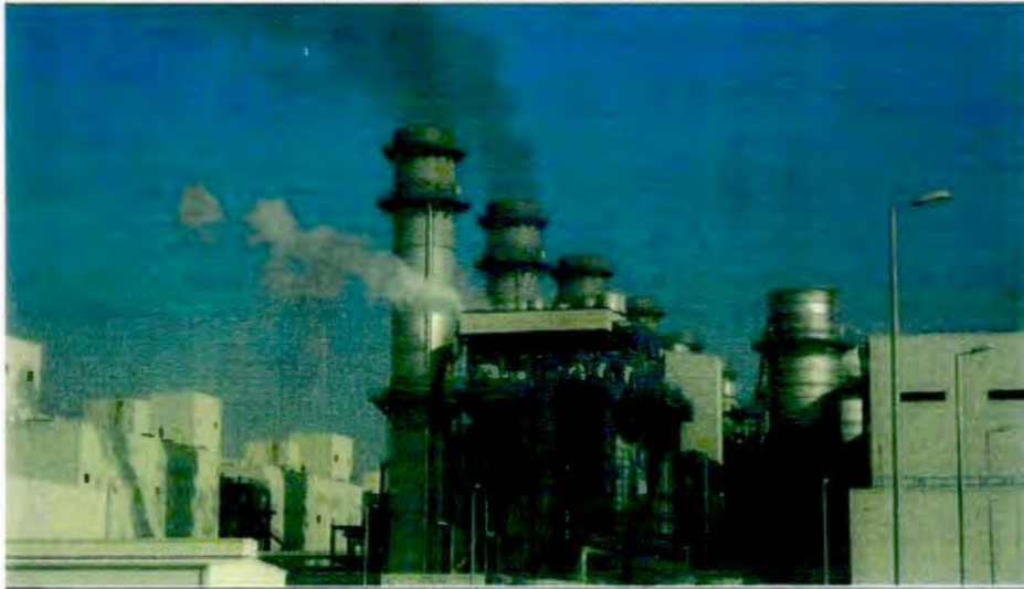
العادم الخارج من المدخنة الرئيسية للغلاية رقم 12 التي تعمل بالاسترجاع الحراري وذلك نتيجة لتنظيف (نفخ) المواسير Power Block # 1 Combined Sigma Blowing
