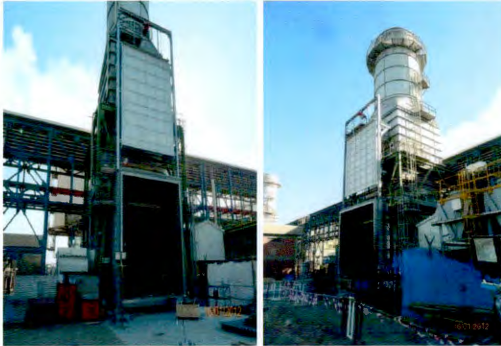
أعمال التركيبات لبوابة تحويل الغازات للوحتين 22 و 31 Erection Works for Diverter Damper Units 22 & 33
